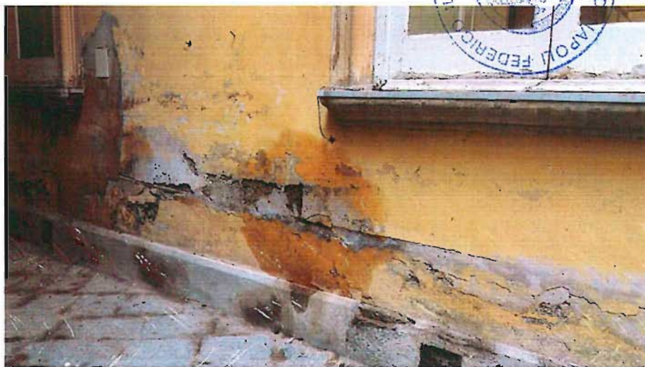
Infiltrazione tubazione cortile di economia
