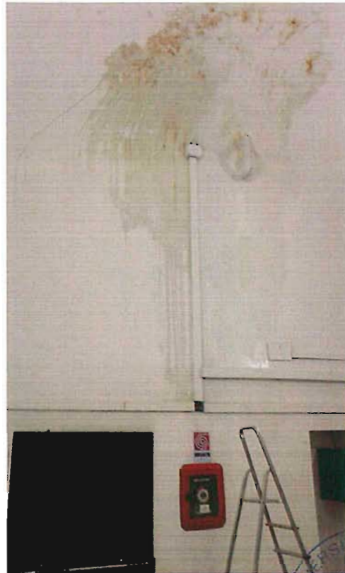
Infiltrazione tubazione cortile di economia
